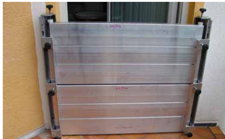
Objektschutz an Gebäudeöffnungen
