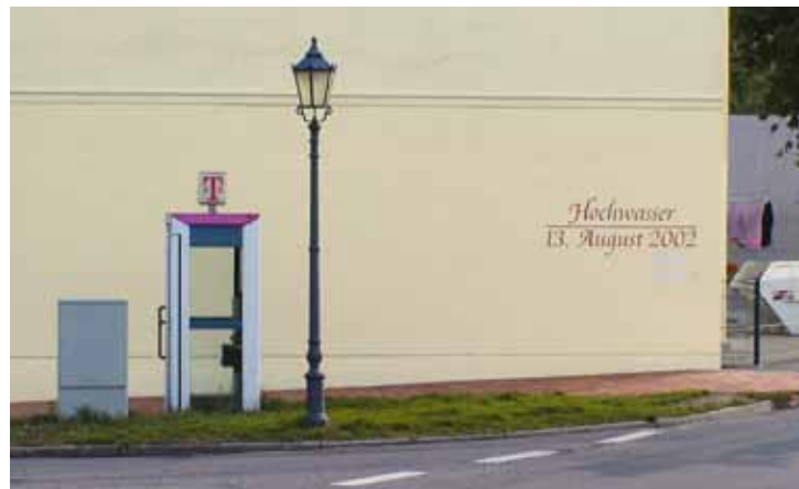
Plakative Hochwassermarken an der Zwickauer Mulde in Colditz
